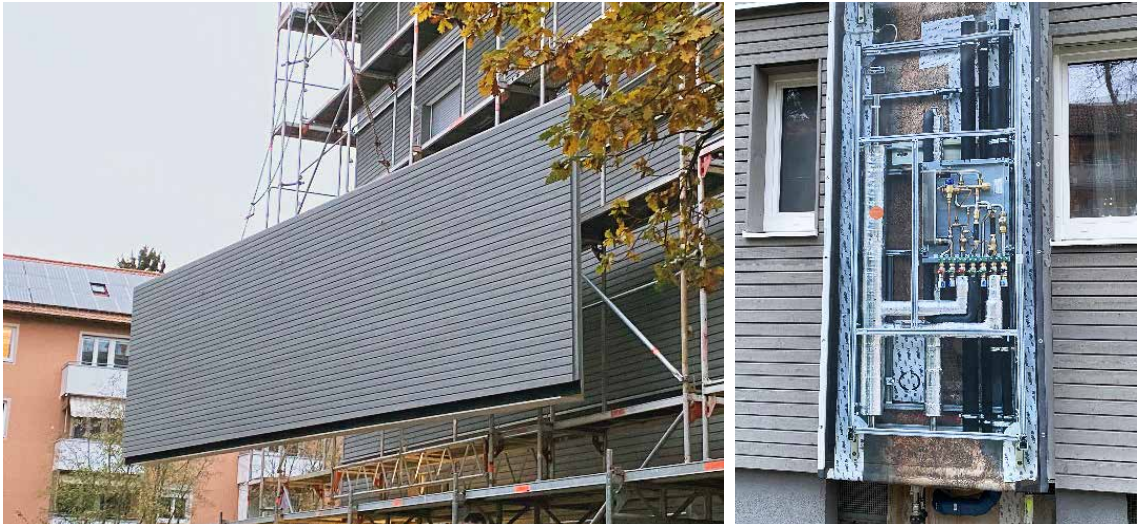
Abbildung 11: Fotos oben links: Montage eines vorgefertigten Wandmoduls; Foto oben rechts: Integration von Haustechnikelementen in die Fassadenebene; Bauherr: Gewobau, Erlangen
