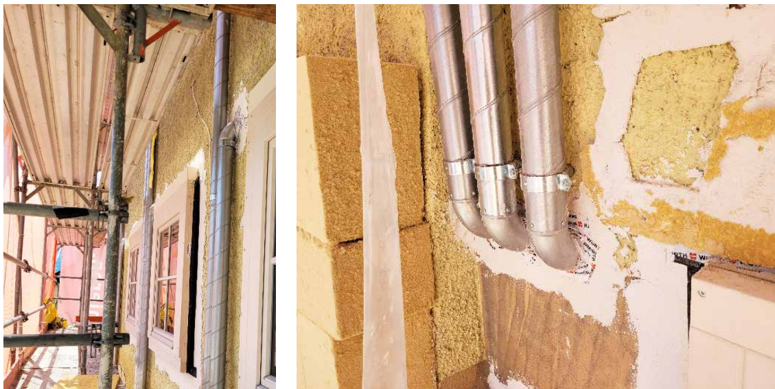
Abbildung 3: Bei der Mustersanierung in der Südtiroler-Siedlung in Bludenz (Projekt SüdSan) wurden die Leitungen der zentralen Lüftungsanlage auf der Außenwand in den Aufbau des Wärmedämmverbundsystems integriert.
